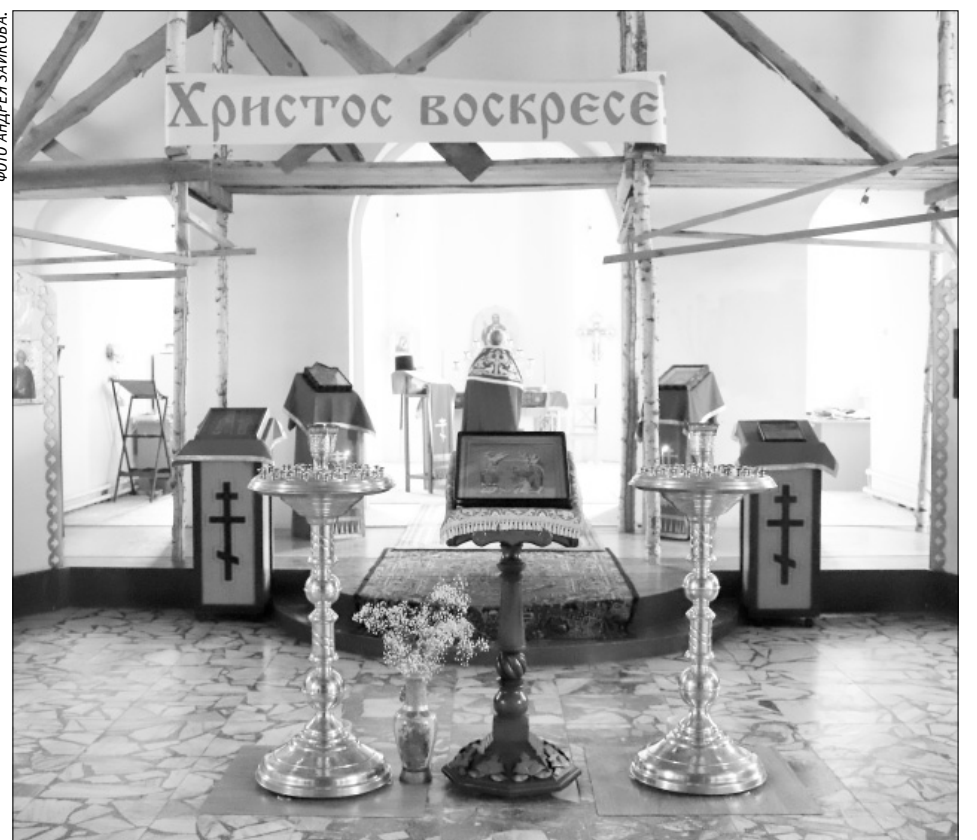
В Покровском соборе уже открыт центральный придел после ремонта, первая служба там была на Пасху.
