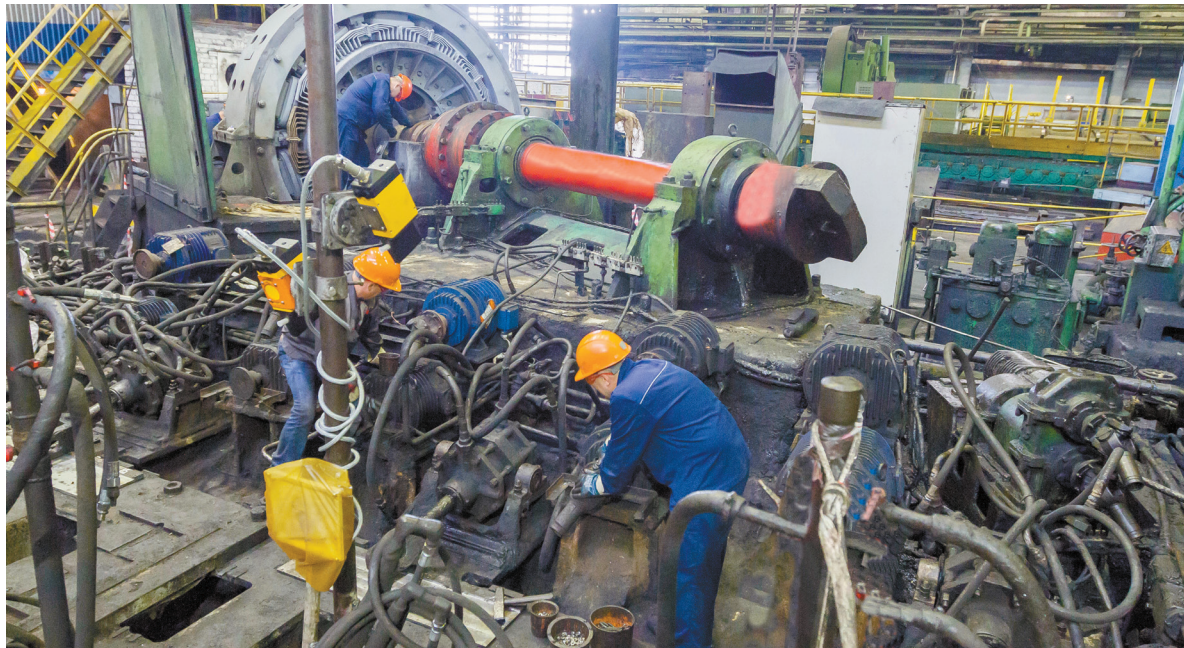
В процессе капитального ремонта ТПА-140
